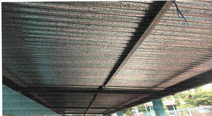
Foto 3: Mantenimiento a estructura de techo y aplicación de anticorrosivo.
