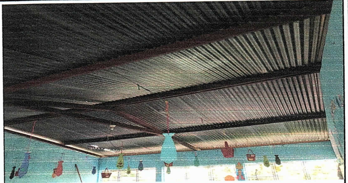
Foto 2: Aula 2 del módulo 2. Mantenimiento a estructura de techo y aplicación de anticorrosivo.
